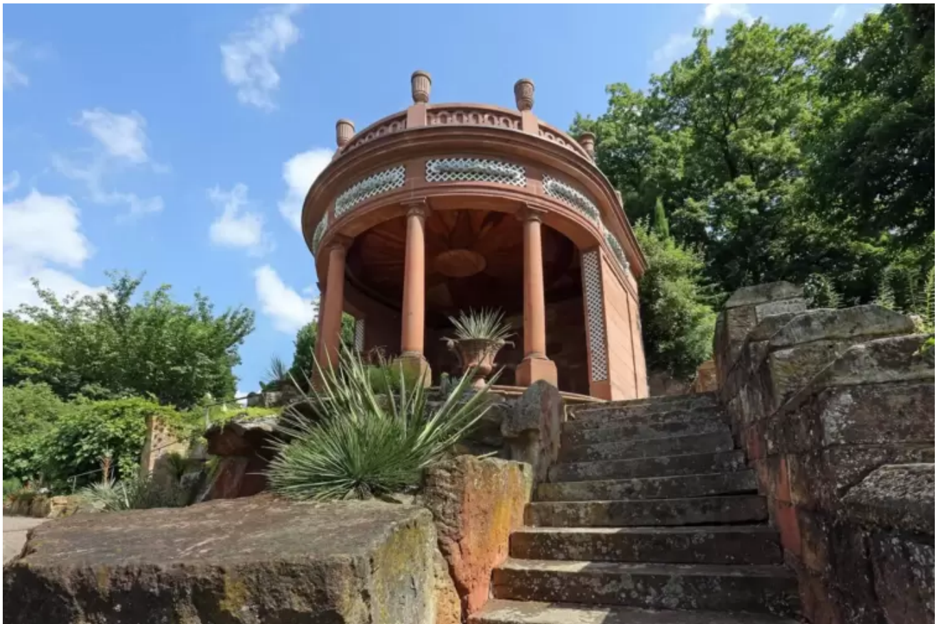
Der Sonnentempel im Park der Privatklinik Gleiszellen stammt ursprünglich aus dem 18. Jahrhundert. | Foto: Norman P. Krauß
